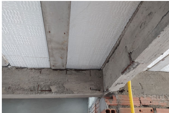
Figura 2 – Imagem de vigas
