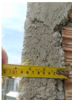
Figura 1 – Imagem do pilar segundo pavimento
