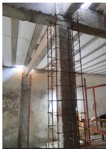
Fonte: Autor (2022) Armação reforço de pilar
