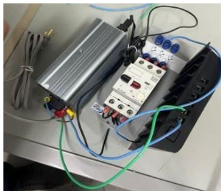
Figura 4 - Instalação dos componentes elétricos
