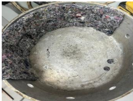
Figura 3 - Instalação do isolamento térmico
