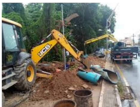
FIGURA 1: Manutenção corretiva Beira Rio 01/2025
