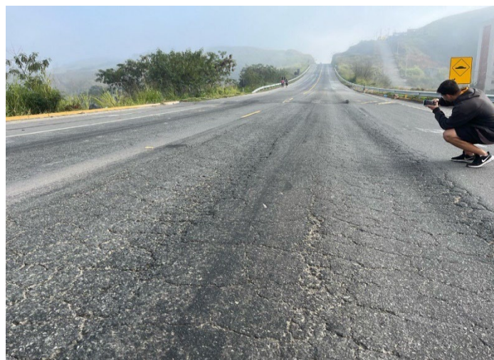
Figura 2: Trilha de Rodas no trecho entre o km 07 e km 09.
