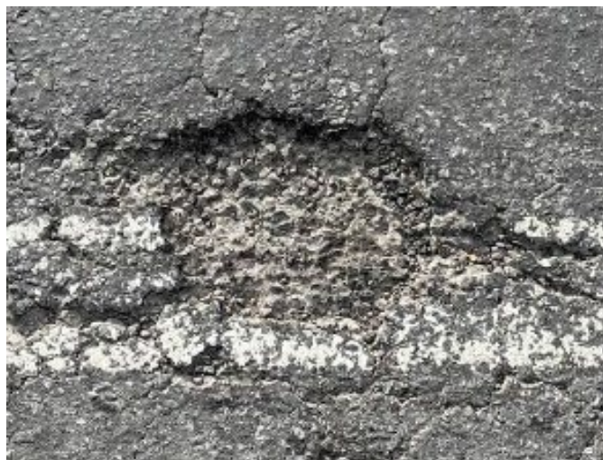
Figura 1: Panela presente no trecho analisado
